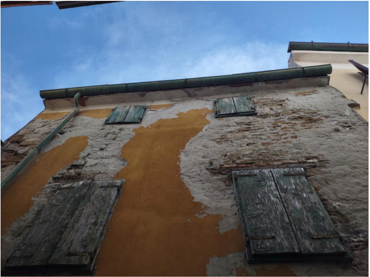
Figura 6 Facciata dell'immobile lato Calle Parini (foto 2022)
